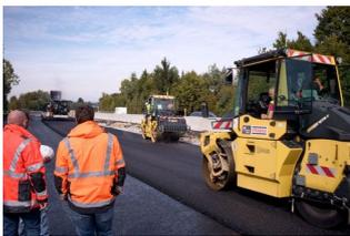
STRABAG testet vollautonomen Asphalteinbau und smarte Absperr-Pylonen
